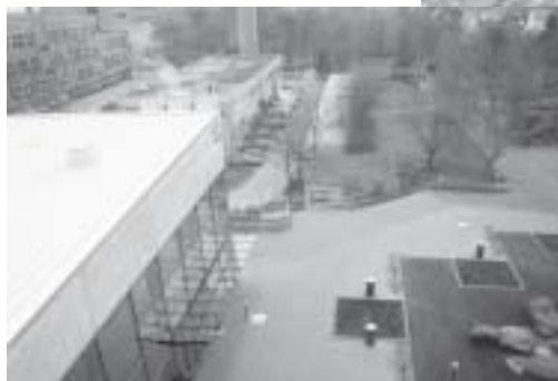
... und nach der Fertigstellung (Fotos: js)
